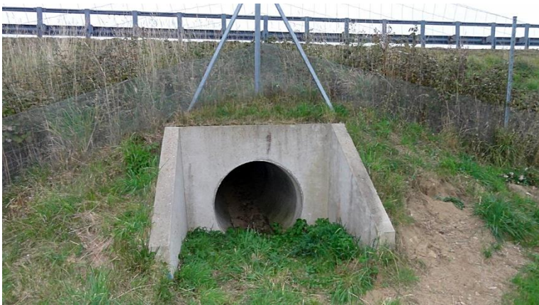
Figure 39: Batrachoduc et clôture spécifique à mailles fines (Source : Egis)
