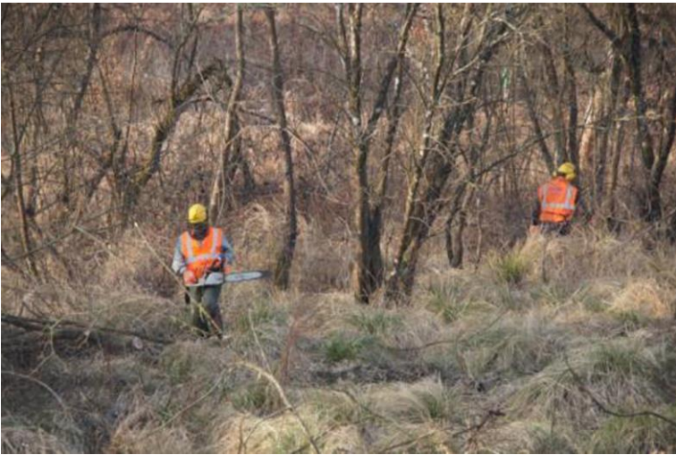
Abattage mécanique d'une ripisylve à 50 cm du sol minimum (P. Fournier - GREGE)
