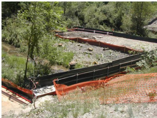
Dérivation en cours de construction avec les protections canalisant les animaux (C. Bout – GREGE)
