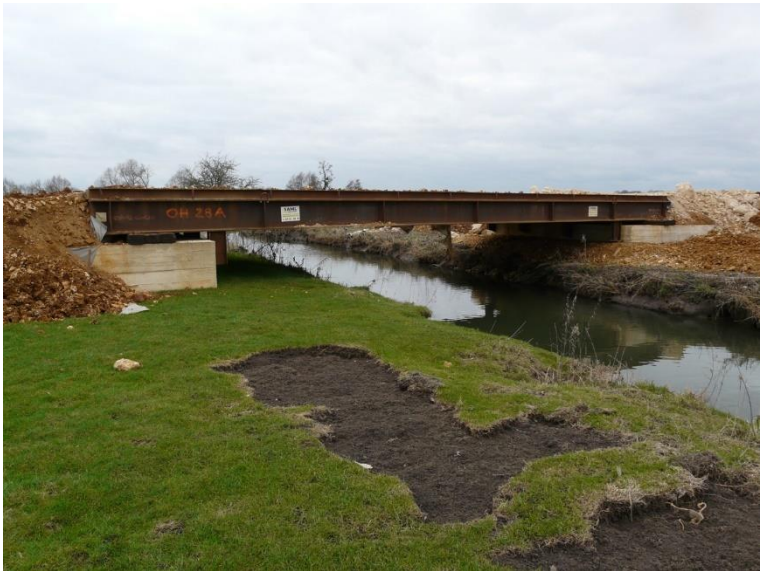
Figure 29: Exemple de pont provisoire (Source : Egis)
