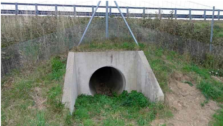
Figure 72: Ouvrage de type 3. (Source : Egis)
