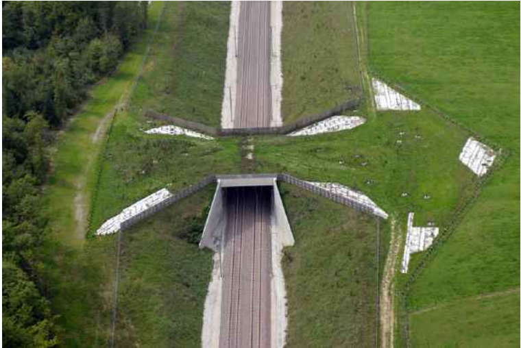
Figure 91: Exemple de passage grande faune
