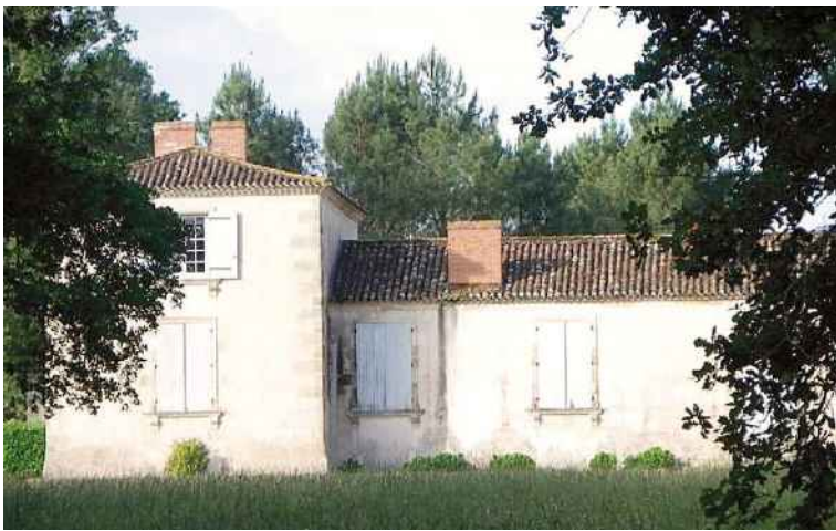
Figure 48: Château du Boscage. (Source : Egis 2012)
