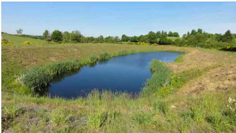
Figure 79: Bassin d’écêtement. (Source : Egis)
