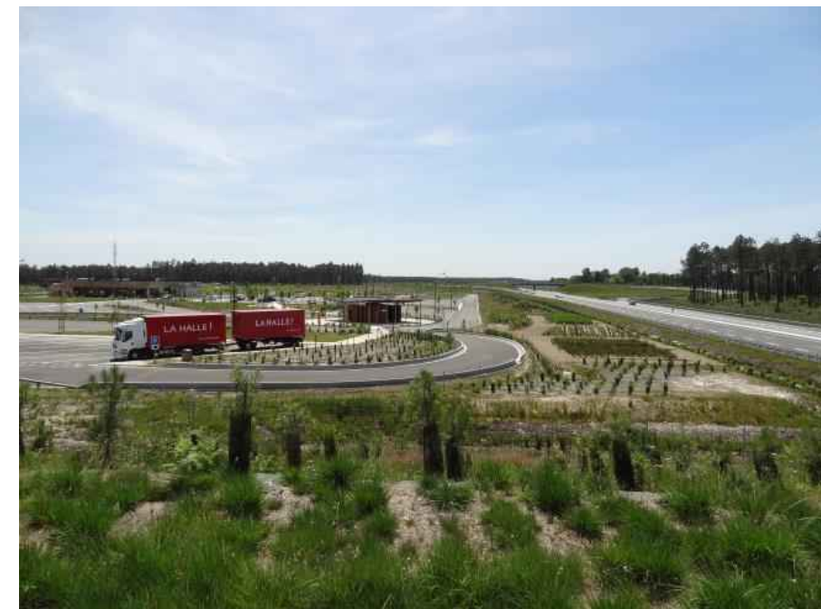
Figure 5: Aire de repos et aire de service (Source : Egis 2012)
