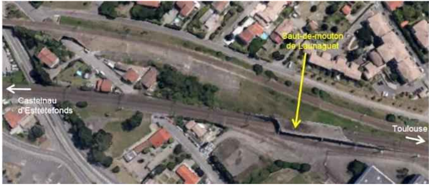
Vue aérienne du saut-de-mouton de Launaguet (Source : SNCF Réseau)
