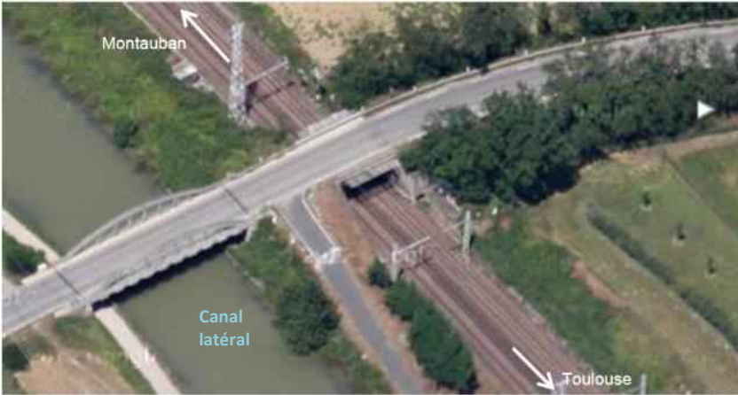
Vue aérienne du pont-route de Bordeneuve (Source : SNCF Réseau)
