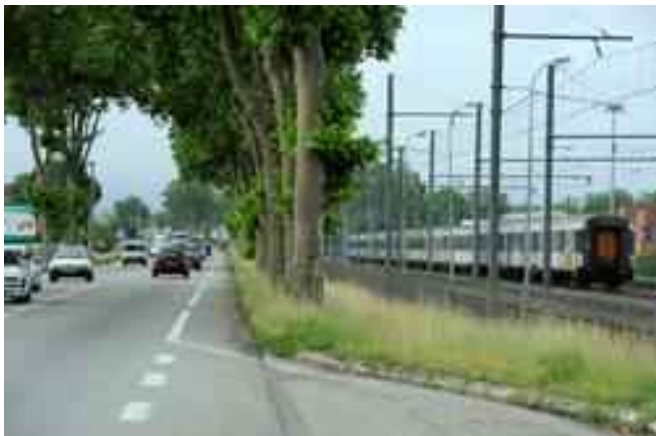
Voie ferrée et M820 (source : SNCF Réseau, 2012)
