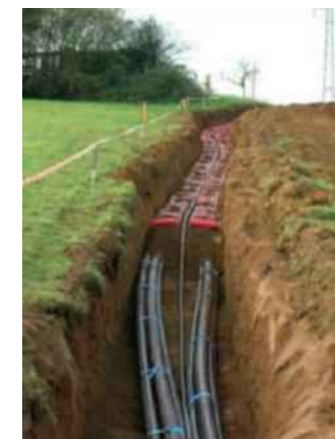
Tranchée avec fourreau PEHD
