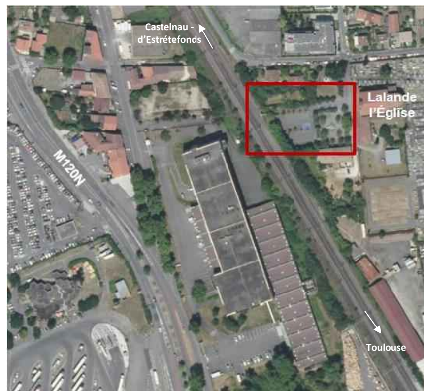
Vue aérienne du site de la halte de Lalande-l'église (Source : Géoportail)
