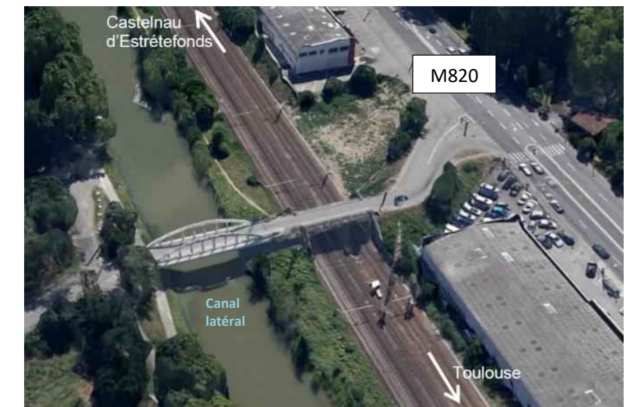
Vue aérienne du pont-route de Rupé (Source : SNCF Réseau)
