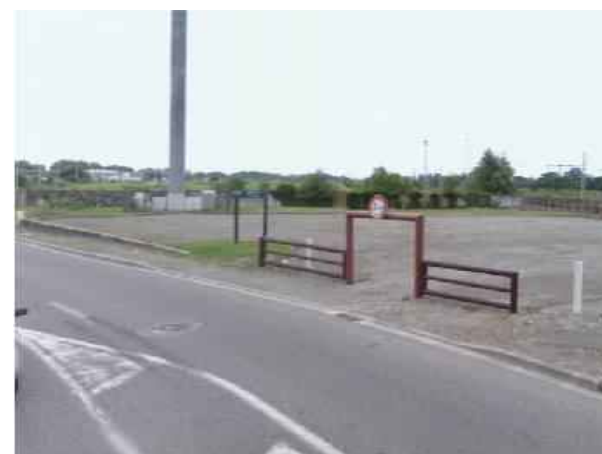
Accès à la halte de Fenouillet (source : SYSTRA, 2012)
