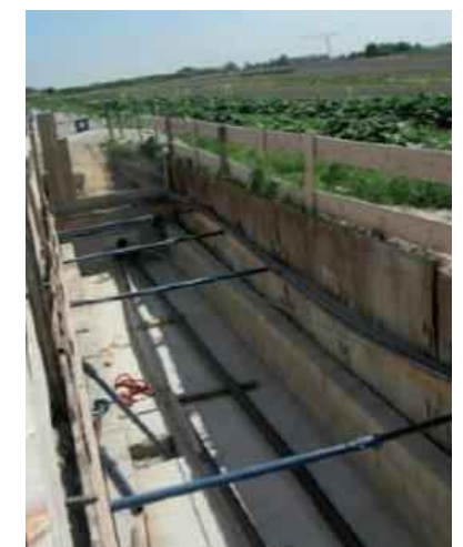
Chambre de jonction
